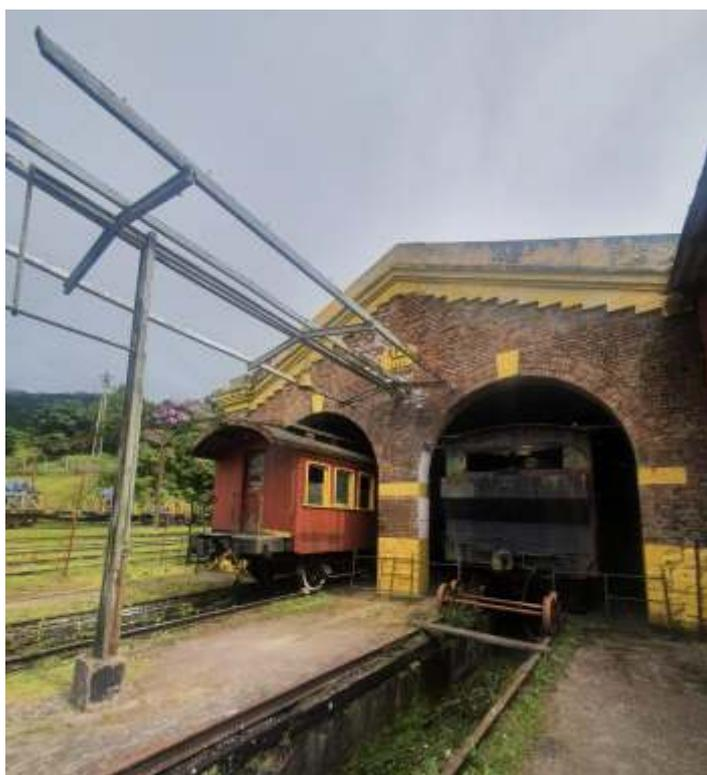
◆ Remoção das telhas de amianto instaladas pela RFFSA no final dos anos 70 que estavam quebradas e soltas da estrutura, ameaçando a segurança dos visitantes.
