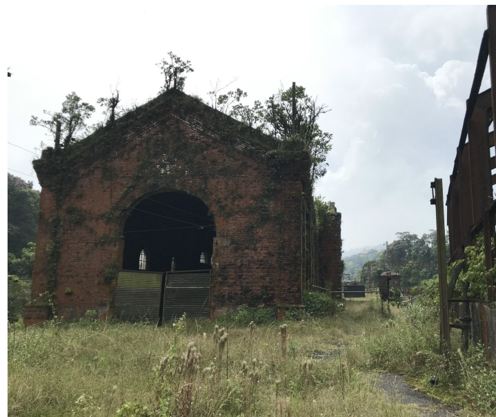
◇ Conjunto - 5ª Máquina - Fachada Norte
