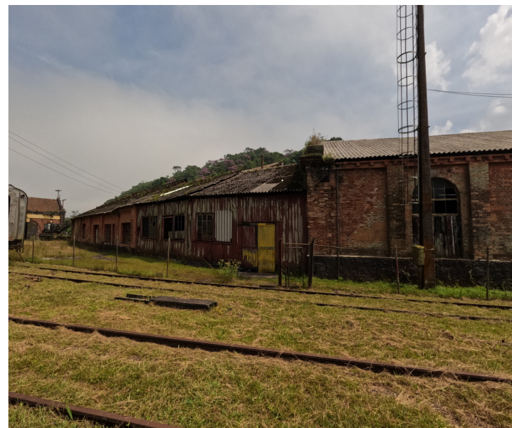
◇ Conjunto - 4ª Máquina - Vista lateral Leste
