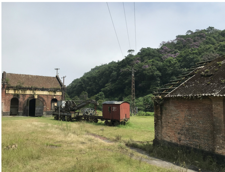
◇ Conjunto - 5ª Máquina - Vista da área externa e fachada Norte
