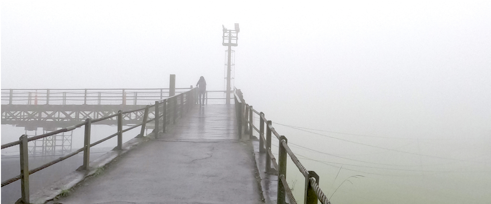
◇ Rampa de acesso à passarela
