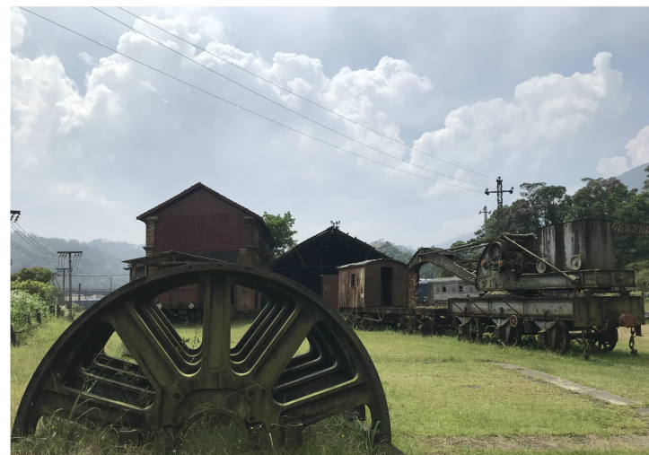
◇ Área externa - Equipamentos remanescentes
