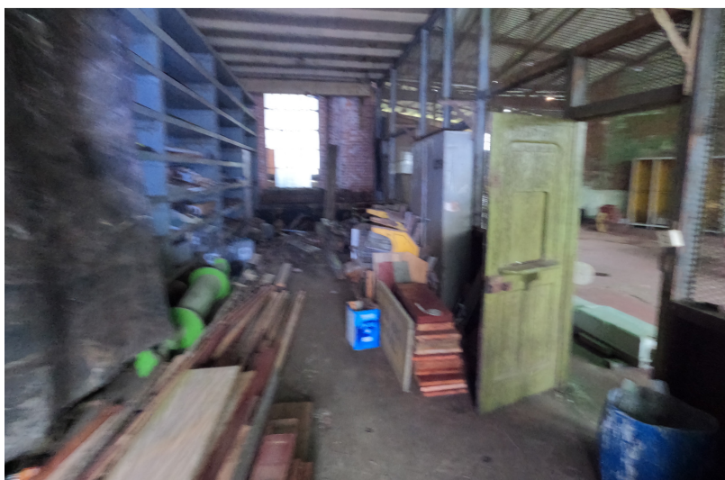
◇ Conjunto - 4ª Máquina - Vista área interna da Reserva Técnica
