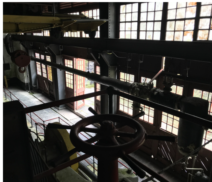
◇ Conjunto - 5ª Máquina Fixa - Área interna
