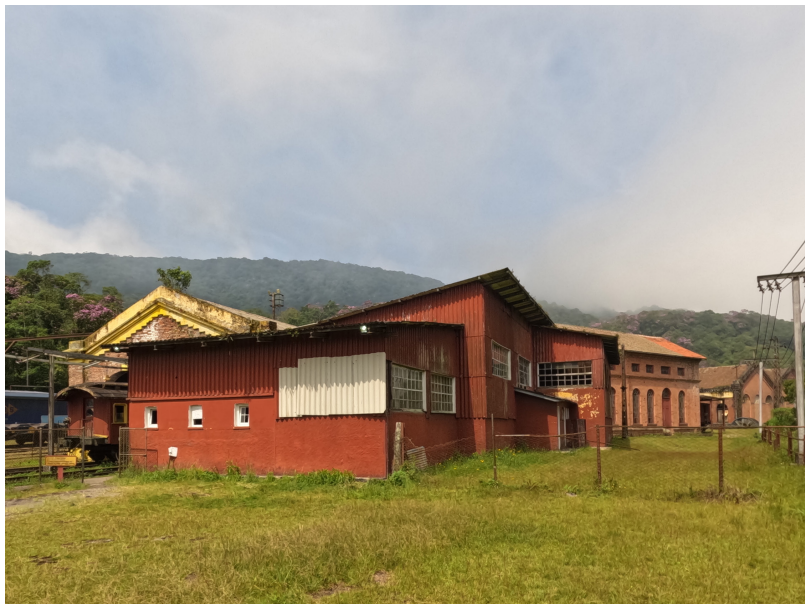
◇ Conjunto - 4ª Máquina - Fachada Norte
