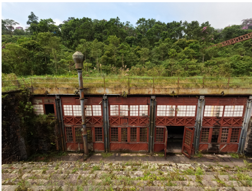
◇ Conjunto - 5ª Máquina Fixa - Fachada
