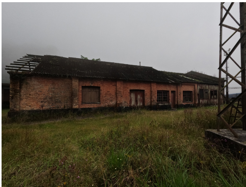
◇ Conjunto - 4ª Máquina - Fachada Leste
