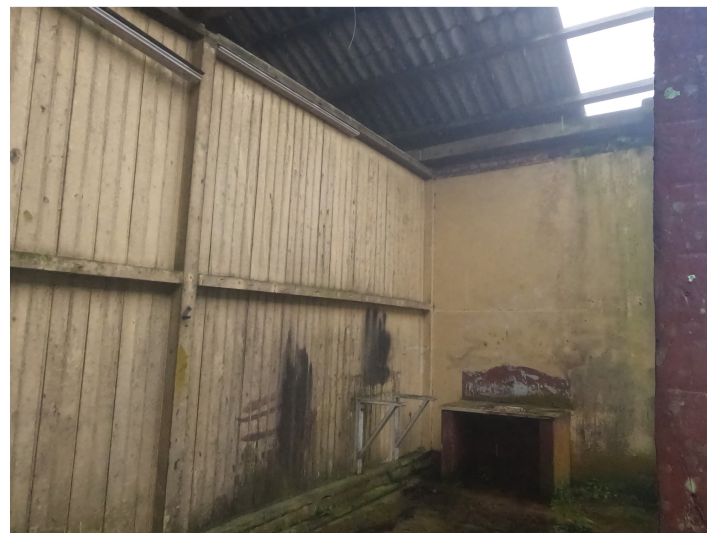
◇ Conjunto - 4ª Máquina - Vista interna para antigo refeitório do "Galpão"
