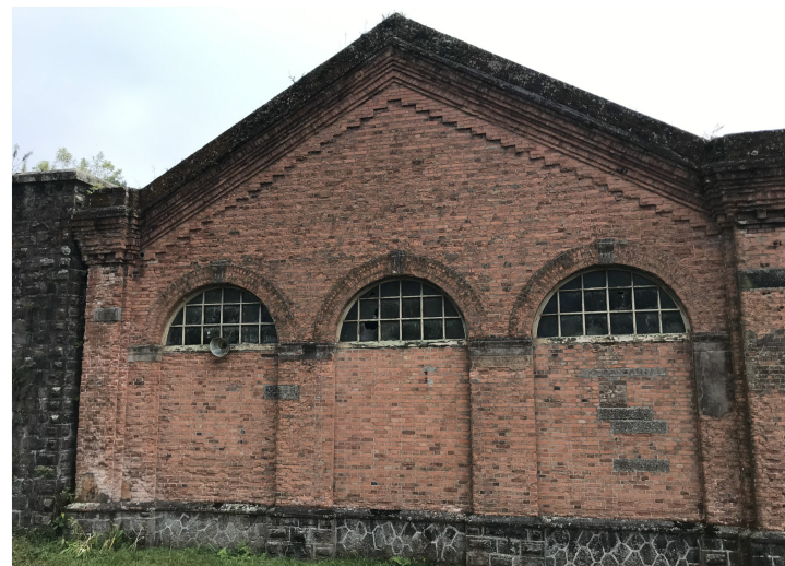
◇ Conjunto - 5ª Máquina - Fachada Leste
