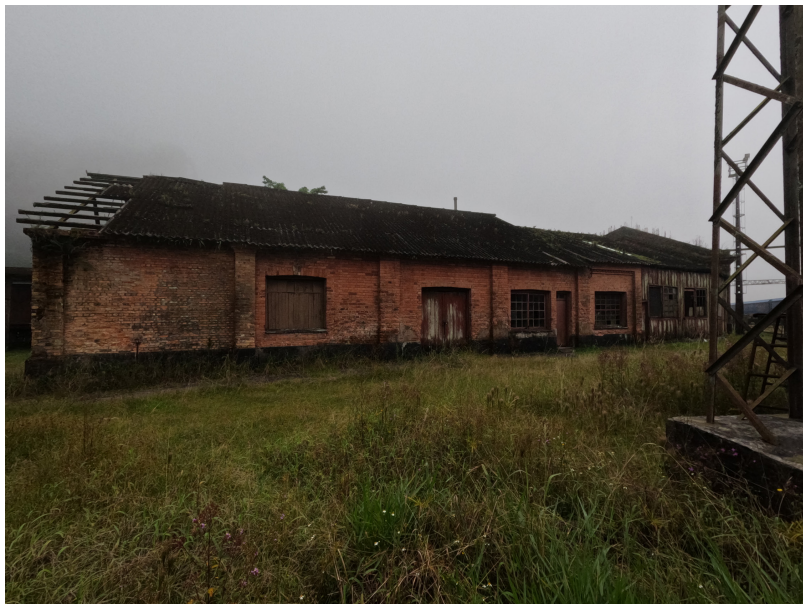
◇ Conjunto - 4ª Máquina - Vista lateral Leste
