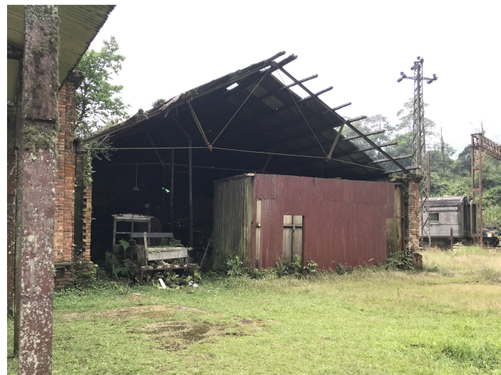
◇ Conjunto - 4ª Máquina - Fachada Sul do "Galpão desativado"
