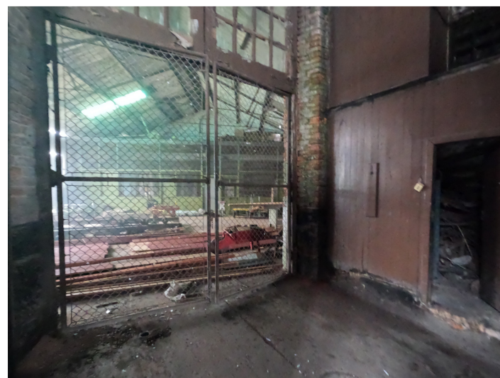
◇ Conjunto - 4ª Máquina - Vista área interna da Oficina
