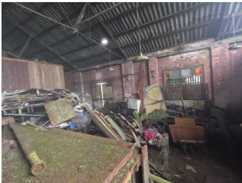
◇ Conjunto - 4ª Máquina - Vista área interna do "Galpão desativado"
