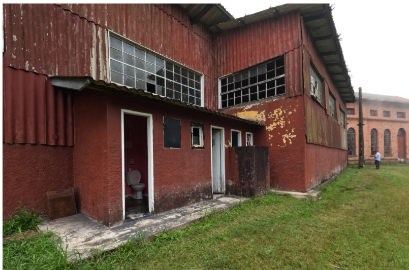
◇ Conjunto - 4ª Máquina - Entrada para os sanitários
