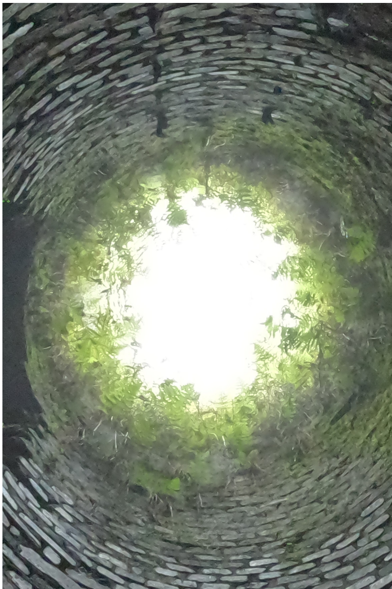
◊ Conjunto - 5ª Máquina Fixa - Vista interna da Chaminé.
