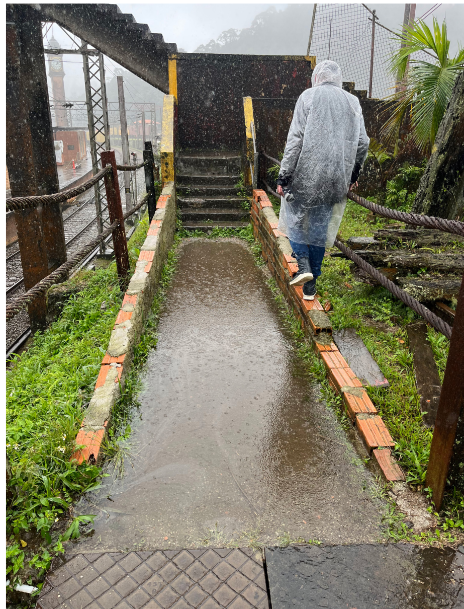
◇ Escada da entrada
