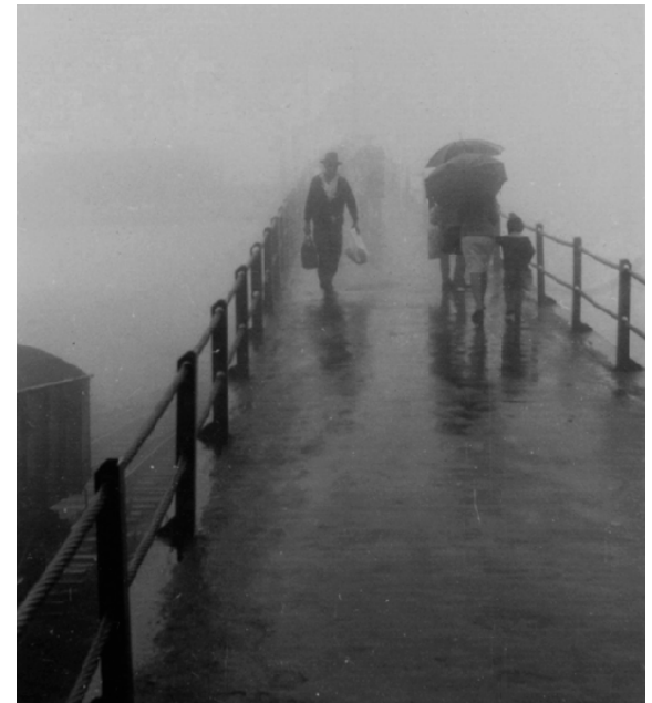
Passarela de acesso dos pedestres até a Estação Ferroviária de Paranapiacaba, década de 1970. Fonte: Acervo Museu de Santo André Dr. Octaviano Armando Gaiarsa.
